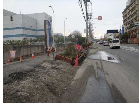
図1 東北地方太平洋沖地震による地盤の液状化 千葉県浦安（気象庁ホームページ）
