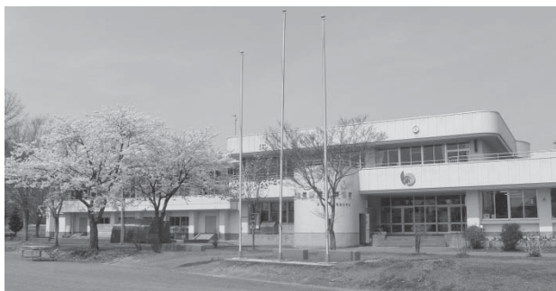
（写真 2）西和賀町立湯田小学校校舎
