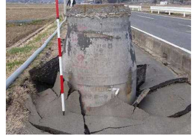
マンホールの浮き上がり (気象庁HPより)
