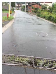
坂道を下った場所の排水溝
