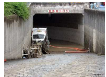
アンダーパスでの冠水
