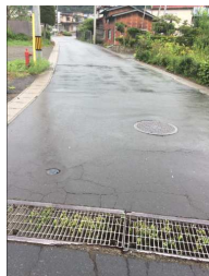
坂道を下った場所の排水溝
