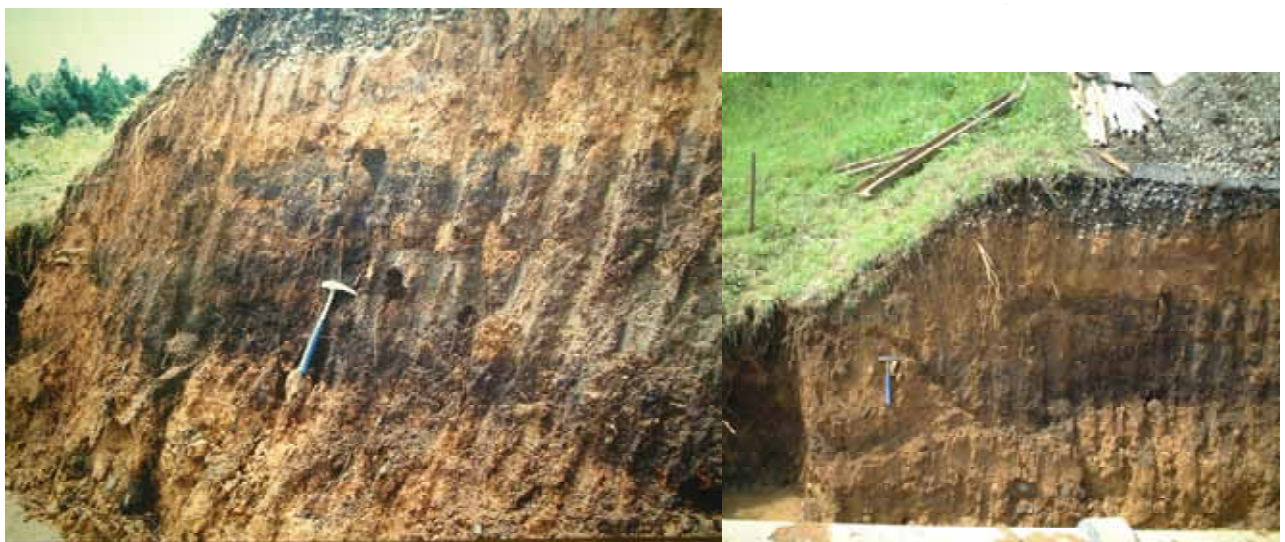
【図3】活断層の露頭写真とスケッチ
