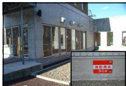
写真コンテンツ⑫（一関市立萩荘小学校の水リサイクル施設）
