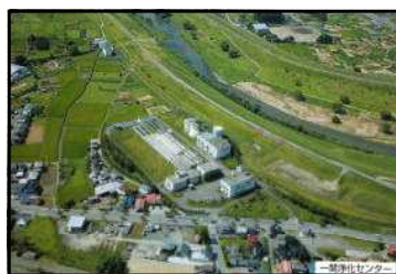
写真コンテンツ③～⑥（県内4カ所の下水処理場の施設）
