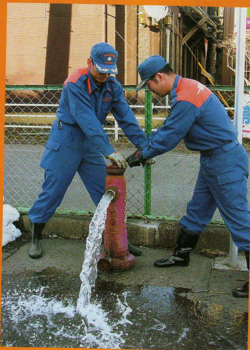
消火せんの点検
